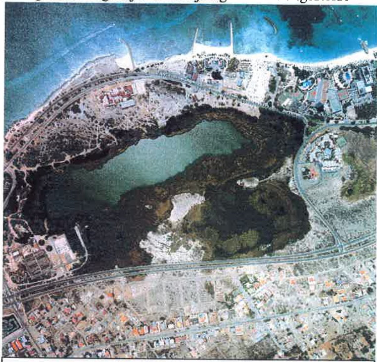
Luchtfoto Bubaliplas en rioolwaterzuiveringsinstallatie, DIP
